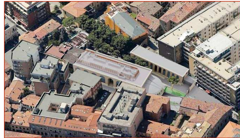
Vista aerea aule complesso Alberti
